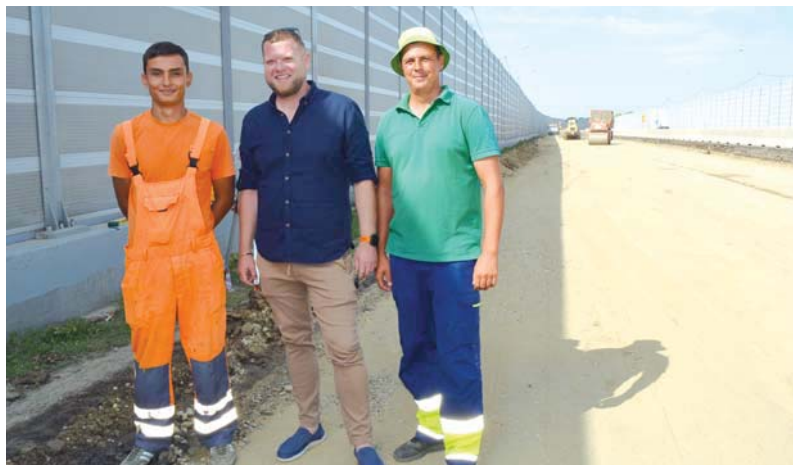
На объекте реконструкции участка автодороги Краснодар — Ейск, 57—58-м километрах, справа налево: опытный производитель работ Игорь Евсеев, главный инженер Константин Леонов и подающий большие надежды молодой дорожник Евгений Зубарев
