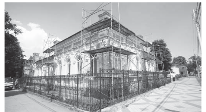
В образовательных учреждениях краевого центра стартовал капитальный ремонт
