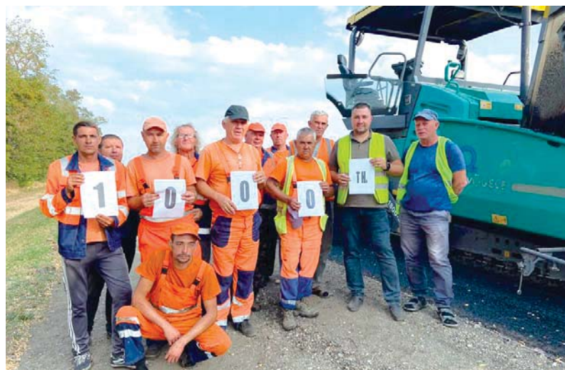
Третьего октября 2023 года этим героям труда удалось уложить тысячу тонн асфальтобетонного покрытия за смену!
