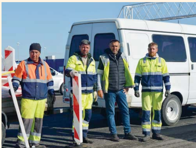
Бригада под руководством прораба Дмитрия Фрусевича готовится к укладке асфальта на участке дороги Краснодар — Кропоткин
