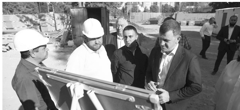
Глава Краснодара Евгений Наумов по итогам рабочего объезда поручил ускорить темпы строительства ФОКов в Карасунском внутригородском округе
