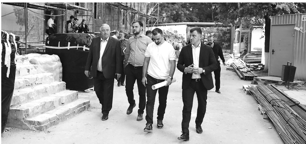
Глава города Краснодара Евгений Наумов во время рабочего объезда проинспектировал ход ремонтных работ в молодежном центре по улице Сормовской, 12/11
