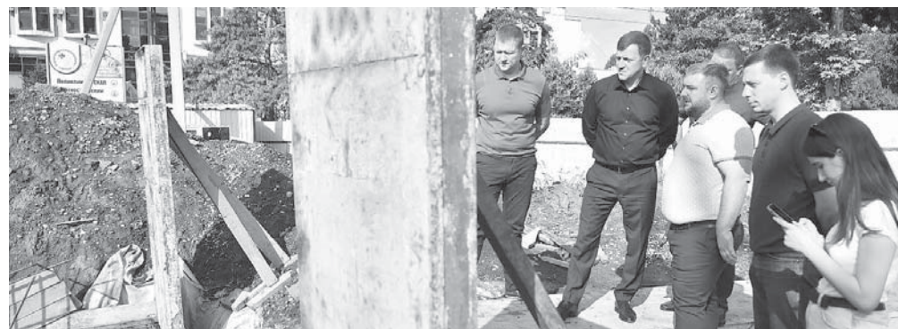
Евгений Наумов во время рабочего объезда проверил ход строительства подземного пешеходного перехода в районе Краевой клинической больницы №2
