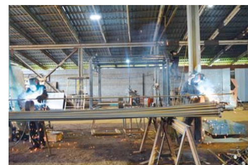
При изготовлении автопавильона необходимы сварочные работы, которые выполняют молодые, но уже опытные электрогазосварщики Андрей Пушков, Андрей Бокарев и Владимир Джелиев
