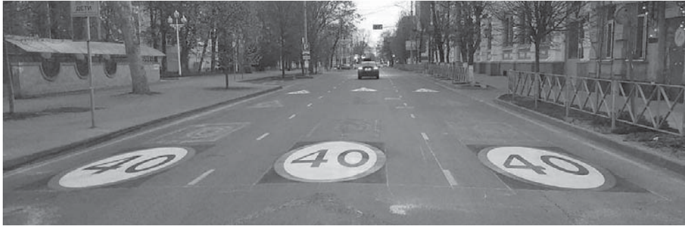
Трафареты с предупреждающими знаками «Дети» и «Ограничение максимальной скорости» уже нанесли с помощью термопластика вблизи восьми школ
