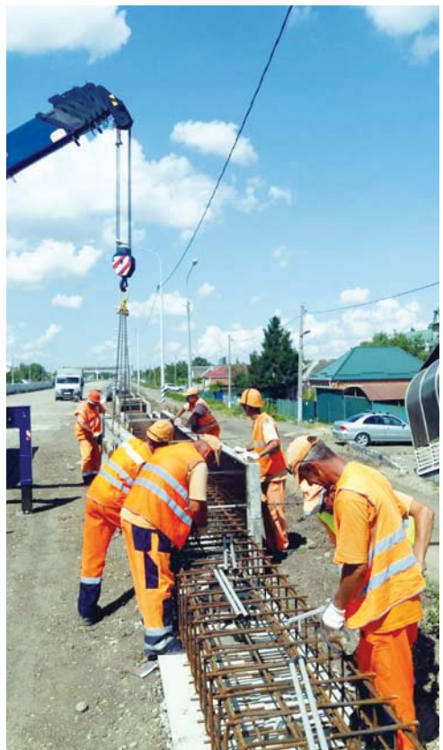
Устройство ростверка
