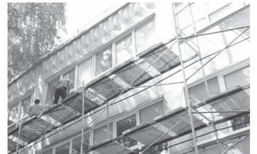
В образовательных учреждениях начались ремонтные работы к новому учебному году
