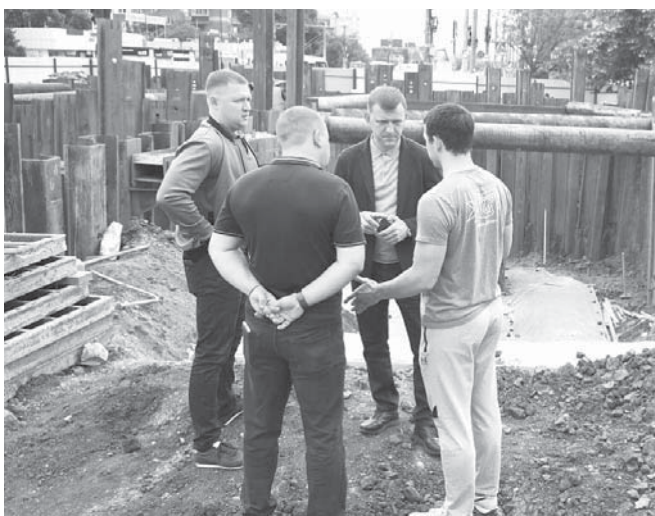
Евгений Наумов проверил ход работ по строительству подземного перехода на улице Красных Партизан
