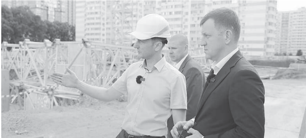
Евгений Наумов проверил ход строительства школы по улице имени Героя Яцкова
