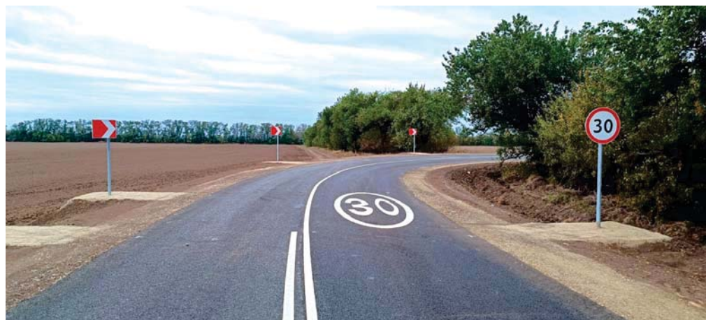
Выполнен ремонт изношенных слоев покрытия на участке а/д подъезд к п. Западный, км 3 + 905, км 5 + 166, в 2022 году
