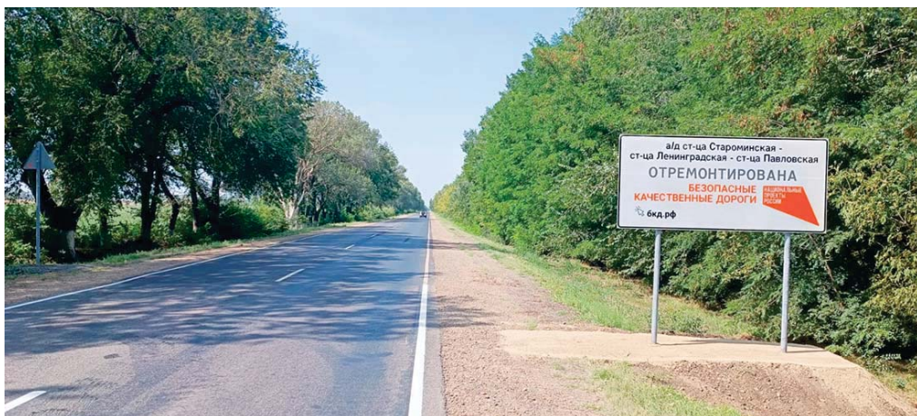
Силами Павловского ДРСУ в этом году был преобразован участок объекта «Автомобильная дорога ст. Староминая — ст. Ленинградская — ст. Павловская, км 69 + 000, км 75 + 094 в Павловском районе»
