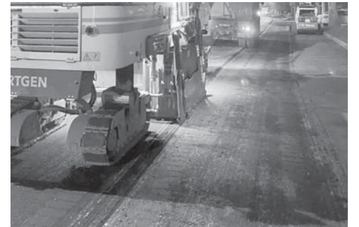
Ремонт дороги на улице имени Фадеева, ведущийся в рамках нацпроекта «Безопасные качественные дороги»
