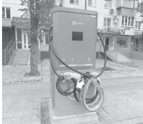
Обустройство станций для зарядки электромобилей в краевом центре
