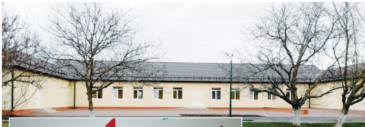
Так выглядит сейчас одно из зданий СОШ №9 после ремонта
