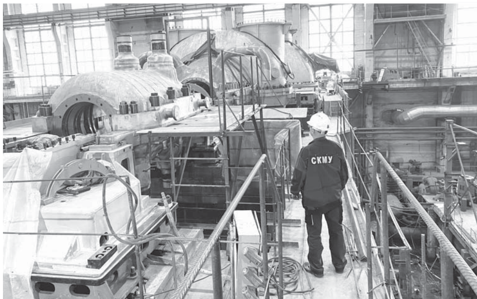
Ремонт паровой турбины на Краснодарской ТЭЦ
