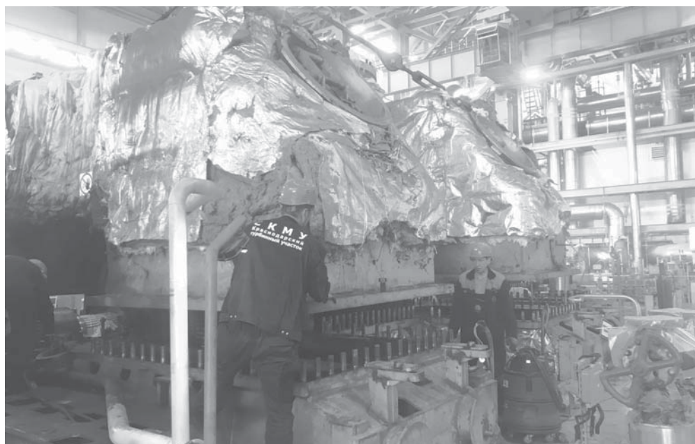
Монтаж паровой турбины на Минской ТЭЦ-3
