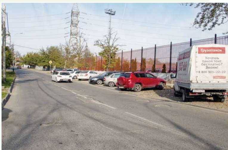
Ул. 2-я Пятилетка до ремонта
