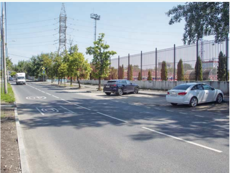
Ул. 2-я Пятилетка после ремонта
