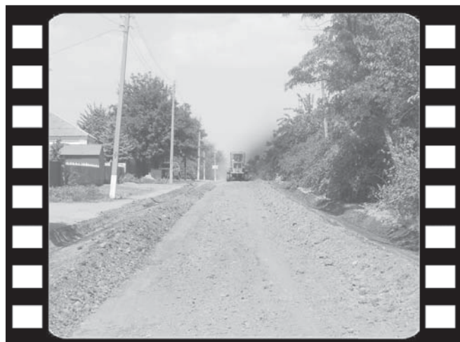
Ремонт дороги по ул. Бейсугской в Переясловской
