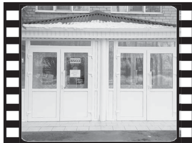
В детском саду «Елочка» проведены работы, в том числе по ремонту входной группы
