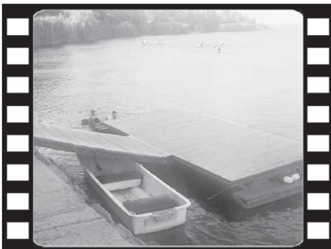
Произведена реконструкция плота и трапа на гребной базе в Брюховецкой
